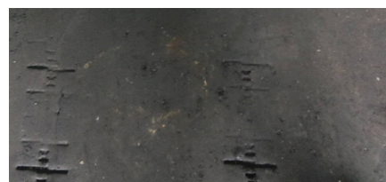
除雪機による凹み
